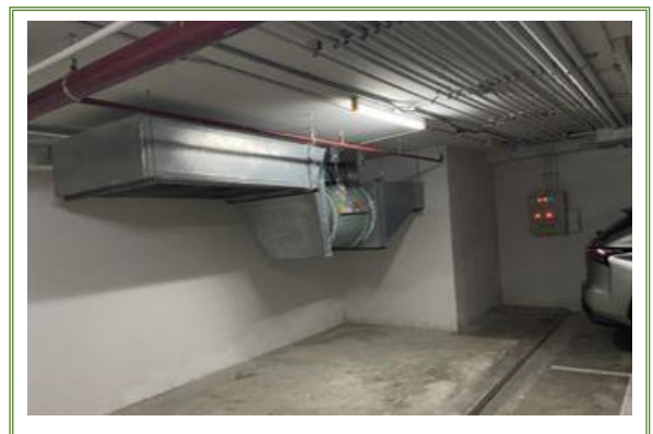
รูปภาพที่ 1.26 รูปภาพพัดลมระบายอากาศลานจอด
