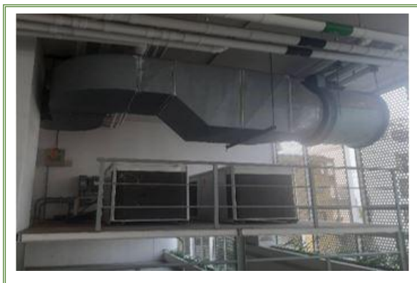
รูปภาพที่ 1.26 รูปภาพพัดลมระบายอากาศลานจอด
